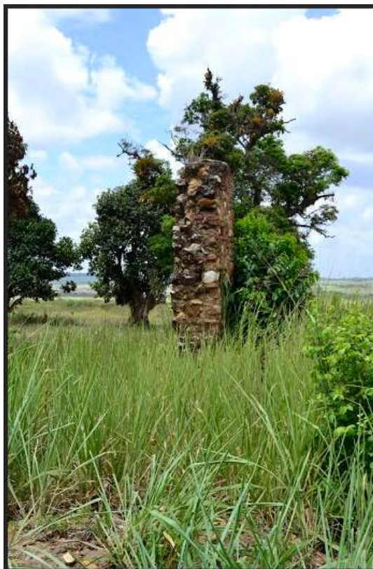
Figura 12: Ruínas da Igreja do Desterro-Itambé PE
